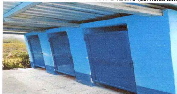
Foto 4: Sustitución de lámina, por lámina troquelada aluzinc calibre 26, elementos de fijación y estructura de techo.
