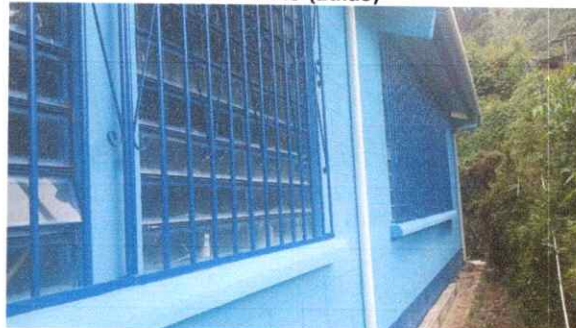
Foto 2: Mantenimiento de 2 balcones de metal: lijado, cepillado y aplicación de pintura
