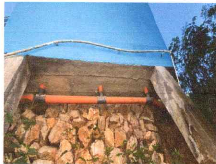
Foto 10: Sustitución de tubería PVC anaranjada línea principal aguas negras
