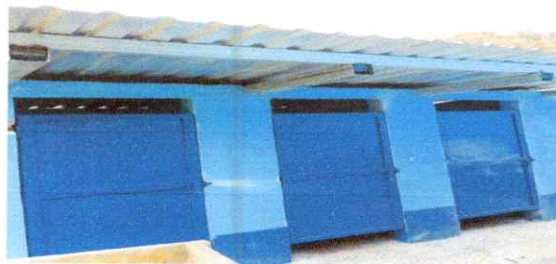
Foto 3: Sustitución de puerta de madera por metal (0.76 m de ancho * 1.40 de alto)
