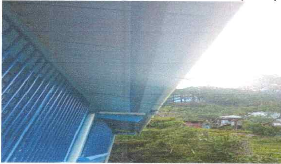
Foto 9: Sustitución de canal de pvc (tubos, codos, tee)
