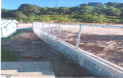
Foto 7: Sustitución de malla galvanizada por malla galvanizada y tubo hg
