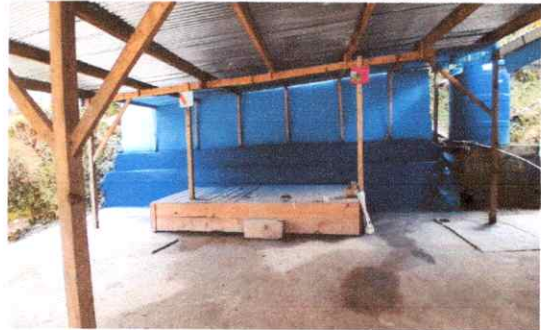
Foto 8: Repello en muros interiores y exteriores
