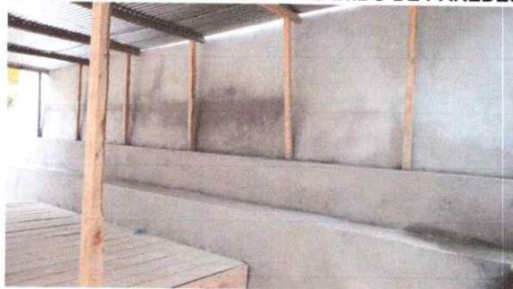
Foto 8: Repello en muros interiores y exteriores
