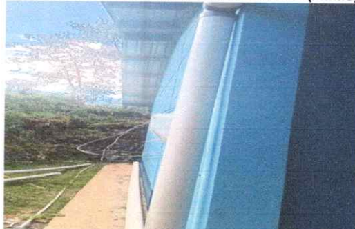
Foto 9: Sustitución de canal de pvc (tubos, codos, tee)
