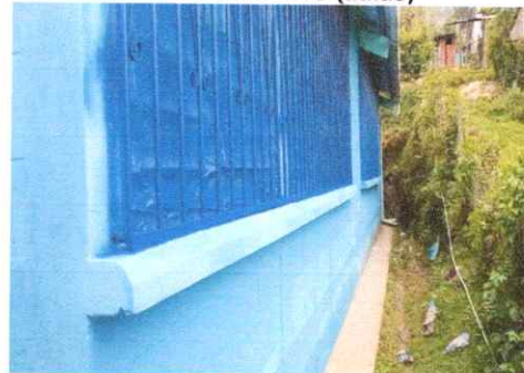
Foto 2: Mantenimiento de 2 balcones de metal: lijado, cepillado y aplicación de pintura
