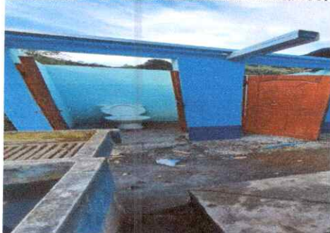
Foto 3: Sustitución de puerta de madera por metal (0.76 m de ancho * 1.40 de alto)
