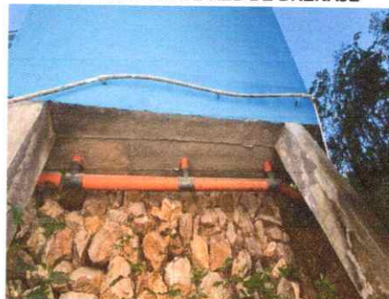
Foto 10: Sustitución de tubería PVC anaranjada línea principal aguas negras
