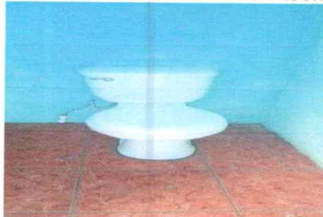
Foto 5: Sustitución inodoro (con accesorios completos)
