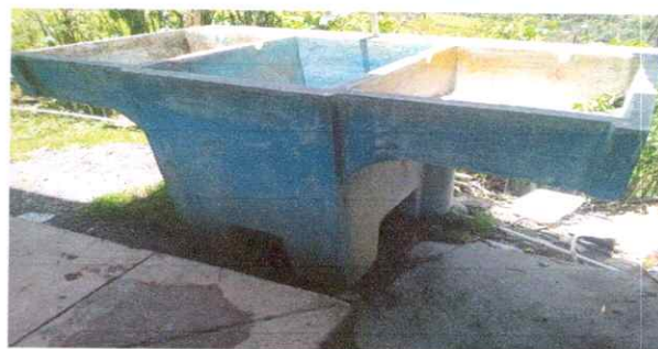
Foto 6: Sustitución de dos pilas de cemento de dos lavaderos
