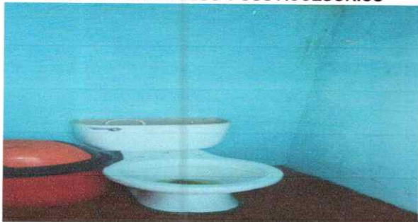
Foto 5: Sustitución inodoro (con accesorios completos)
