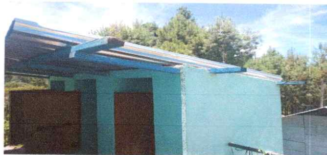
Foto 4: Sustitución de lámina, por lámina troquelada aluzinc calibre 26, elementos de fijación y estructura de techo.
