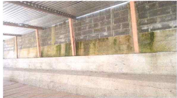
Foto 8: Repello en muros interiores y exteriores
