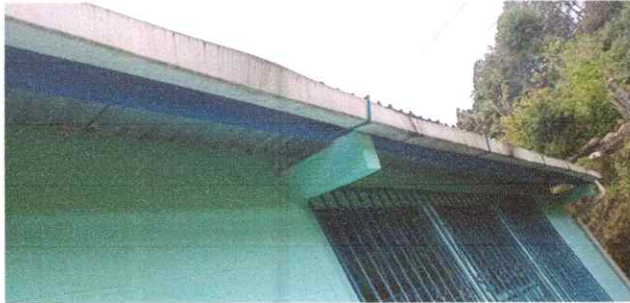
Foto 9: Sustitución de canal de pvc (tubos, codos, tee)
