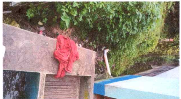
Foto 10: Sustitución de tubería PVC anaranjada línea principal aguas negras
