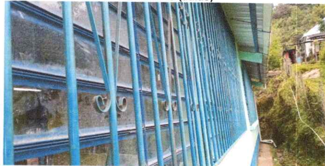
Foto 2: Mantenimiento de 2 balcones de metal: lijado, cepillado y aplicación de pintura
