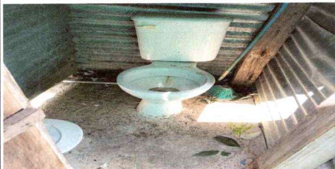
Foto 3: Sustitución de inodoros con accesorios completos.
