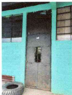
Foto 5: Sustitución de puertas con chapa, aula, dirección y 3 de servicios sanitarios.
