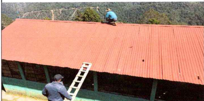
Foto1: Sustitución de lámina ondulada, por lámina troquelada aluzinc calibre 26 color gris metálico, capotes y elementos de fijación. También instalación de canal de PVC.
