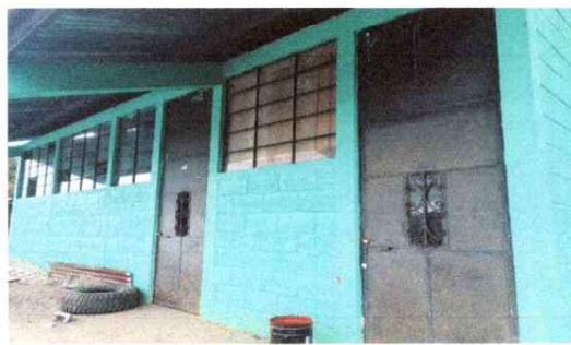
Foto 6: Sustitución de vidrios en ventanas de aula y dirección.
