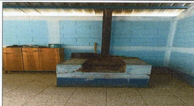
Foto 3: Chimenea deteriorada
