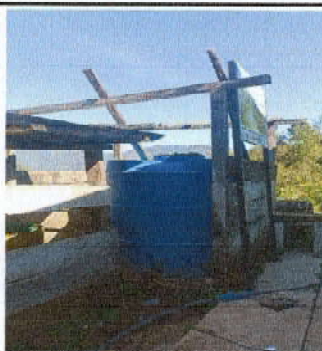
Foto 5: Pilares del techo de deposito de agua destruido.
