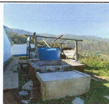
Foto 6: Paredes y techo de deposito de agua destruido y deteriorado.
