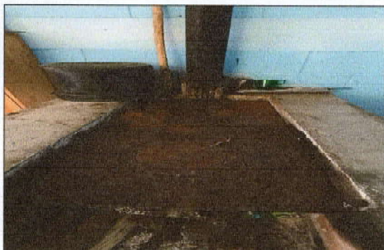
Foto1: Plancha oxidada
