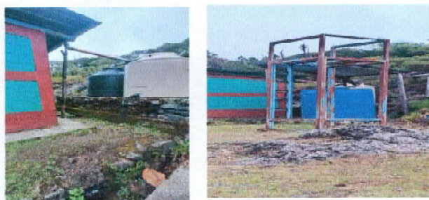
Foto 10: Reparacion y mantenimiento de cisternas o depositos de Agua
