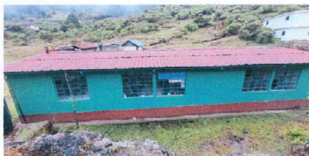
Foto 1: Cubierta de lamina (2 aulas, 1 cocina, 4 baños, 1 base est. Tinaco)
