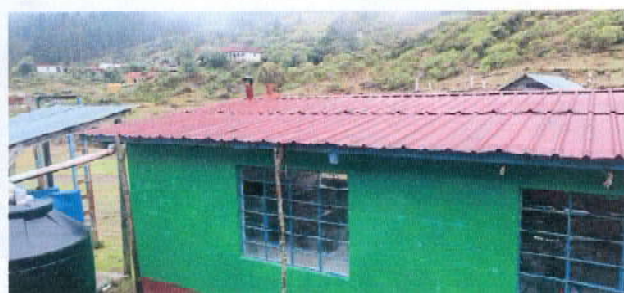
Foto 5: Canales y bajadas de agua pluvial (3 aulas)
