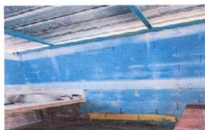
Foto 6: Pintura en muros exteriores e interiores
