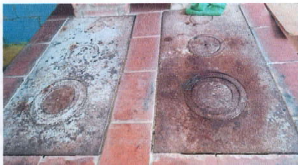
Foto 11: Reparacion de cocina
