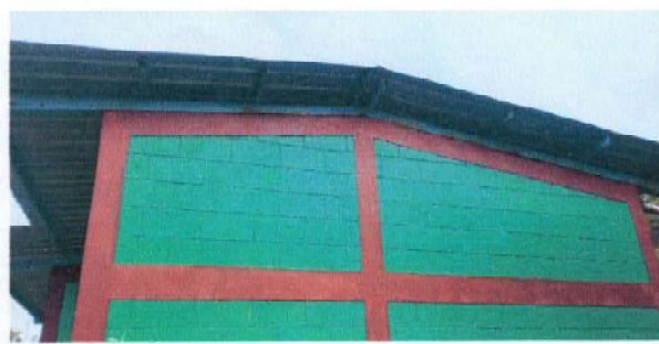
Foto 2: Estructura: (techo, aula, baños, y base est. Tinaco)
