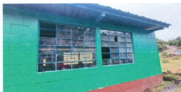
Foto 4: Ventanas (2 aulas, 1 cocina)
