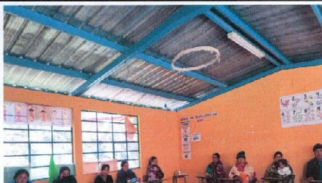
Foto 9: sistema Electrica ( y accesorios)
