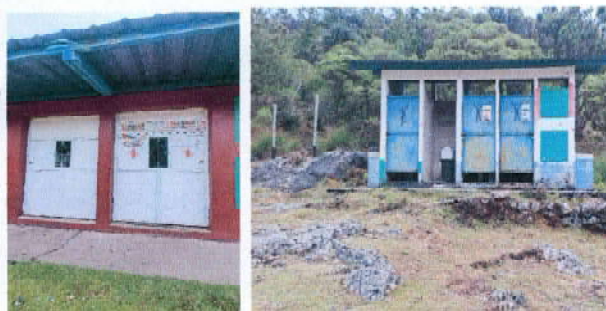
Foto 3: Puertas de metal (2 aulas, 1 cocina, 4 baños)
