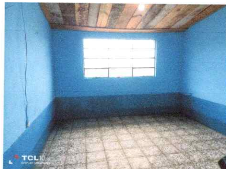
Foto 14: Sistitucion de piso de cemento torta por piso granito
