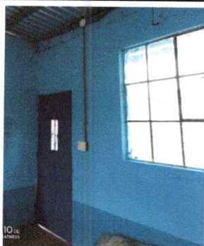
Foto 14: instalacion de tomacorrientes y apagadores
