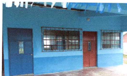
Foto 15: Pintura en muros interiores y exteriores de las aulas que se les coloco piso granito
