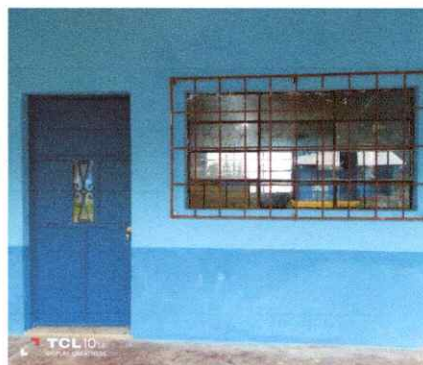
Foto 10: Mantenimiento en ventanas y colocación de vidrios, sustitución de chapa de la puerta y su mantenimiento
