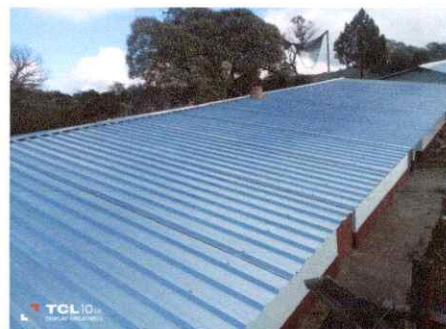
Foto 12: Sustitución de lámina en aula y cocina
