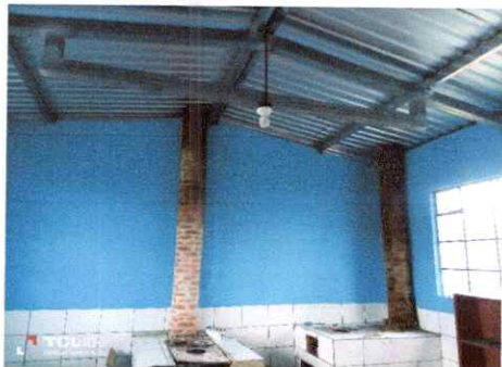
Foto 13: Sustitucion de sistema electrico en aulas y cocina
