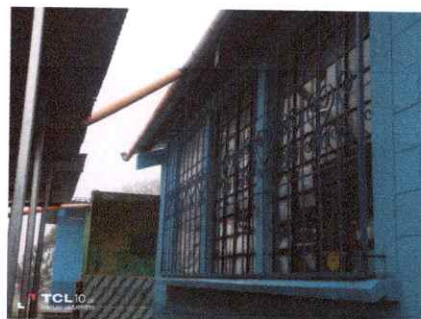
Foto 17: Instalación de balcones parte posterior
