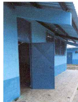
Foto 8: Mantenimiento a tres puertas (3 aulas) del centro educativo INEB de Telesecundaria
