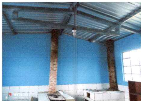
Foto 11: Sustitución de estructura metálica en aula y cocina
