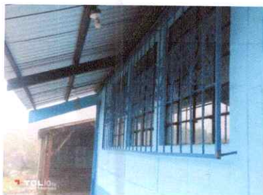
Foto 16: instalación de balcones de metal parte frontal
