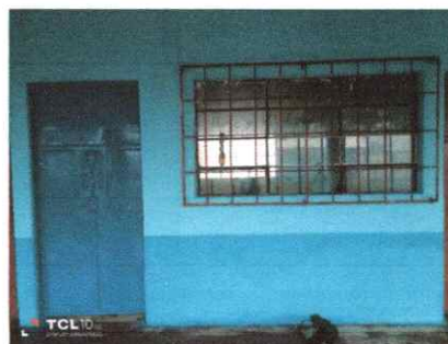
Foto 10: Mantenimiento en ventanas y colocacion de vidrios
