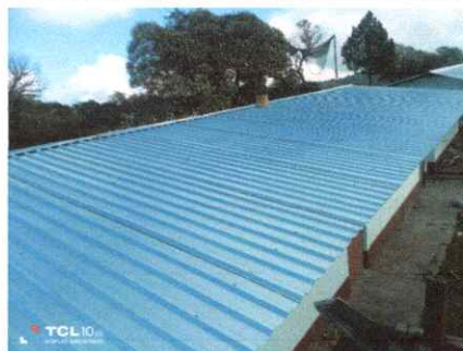
Foto 12: sustitucion de lamina en aula y lamina
