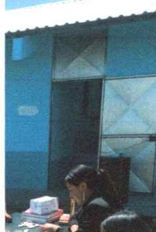
Foto 8: Preparacion para mantenimiento a tres puertas (3 aulas) del centro educativo INEB de Telesecundaria
