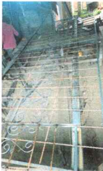
Foto 5: Armado de balcones para sustitucion
