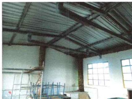
Foto 11: Sustitucion de estructura metalica en aula y cocina
