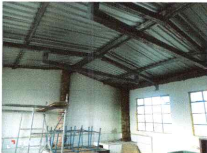
Foto 13: Preparacion para sustitucion de sistema electrico en aulas y cocina
