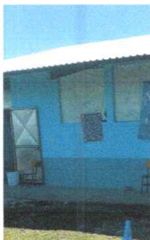
Foto 7: Preparacion de puerta para cambio de chapa de tres puertas (3 aulas) del centro educativo INEB de Telesecundaria
