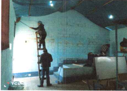
Foto 1: Limpieza e impermeabilización para aplicación de repello y sernido de muro de blok en interior de muros de aulas del centro educativo INEB De Telesecundaria
