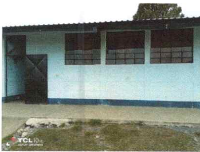
Foto 3: limpieza en muros de INEB De Telesecundaria, exteriores par aplicar pintura
