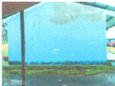
Foto 2: Impermeabilización, repello y sernido de muro de blok en exterior de muros de aulas del centro educativo INEB De Telesecundaria
