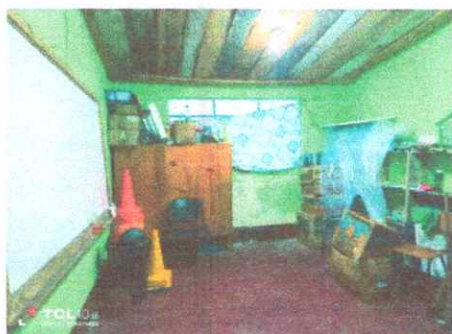
Foto 9: Sustitución de piso de cemento torta por piso granito
