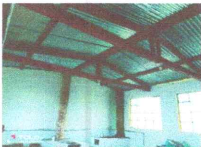
Foto 11: Sustitución de estructura metálica en aula y cocina
