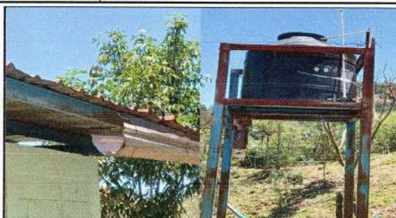
Foto 2: ESTRUCTURA (TECHO - AULAS, COCINA, BAÑOS Y BASE EST. DE TINACO)
