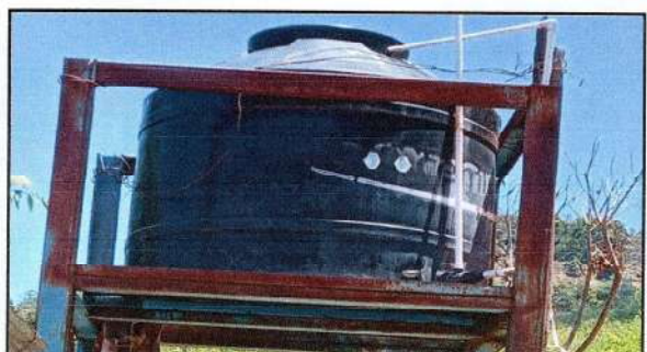
Foto 10: REPARACIÓN Y MAN. DE CISTERNAS Ó DEPOSITOS DE AGUA
