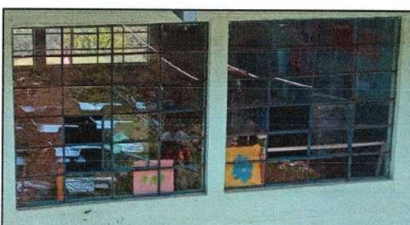
Foto 4: VENTANAS (2 AULAS + 1 COCINA).
