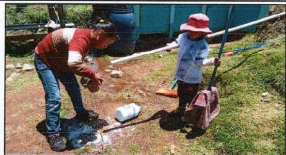
Foto 8: REPARACIÓN DE RED DE DRENAJE Y RED DE AGUA
