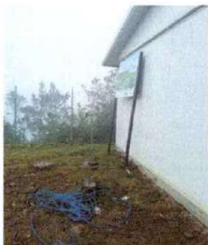
Foto 13: Es fundamental sustituir los recipientes actuales, como toneles y ollas, por un depósito y un sistema de distribución de agua adecuado. Esto garantizará un suministro de agua seguro y eficiente para los estudiantes y personal.
