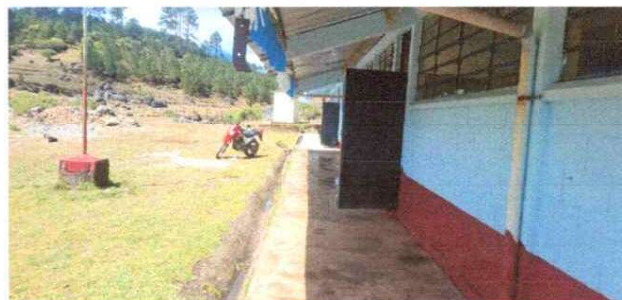
Foto No 4. Sustitución de piso torta por granito
