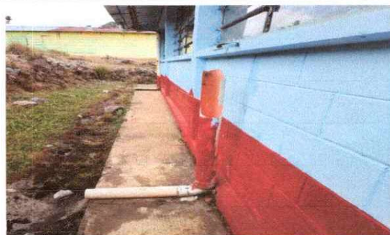
Foto No 12. Bajadas de agua pluvial y canales en mal estado
