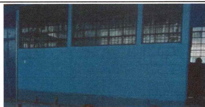
Foto 5 Pintura en muros exteriores e interiores
