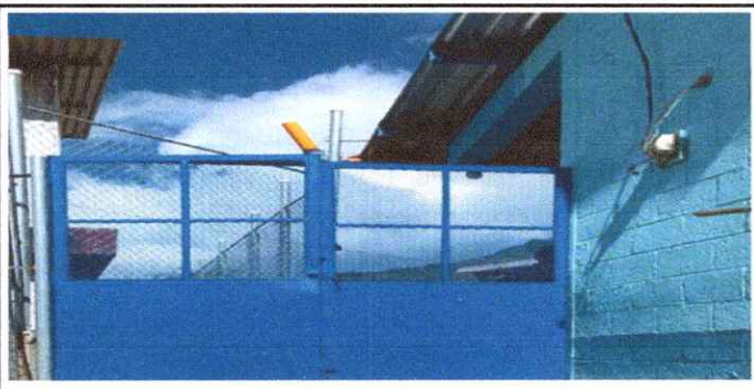
Foto 6 Mantenimiento a portones de metal
