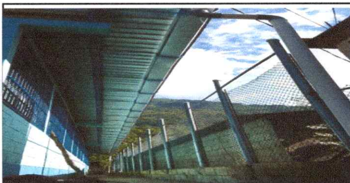
Foto 3 Reparación de bajada de agua pluvial, tubo PVC 3"
