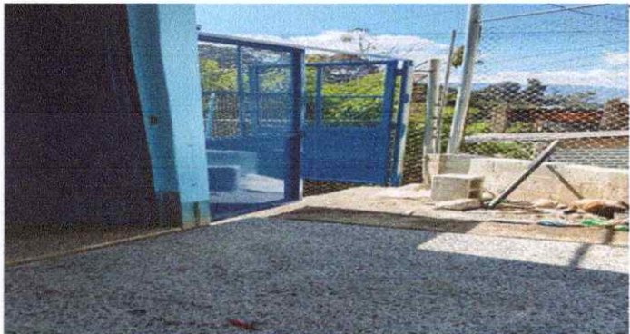
Foto 6 Mantenimiento a portones de metal
