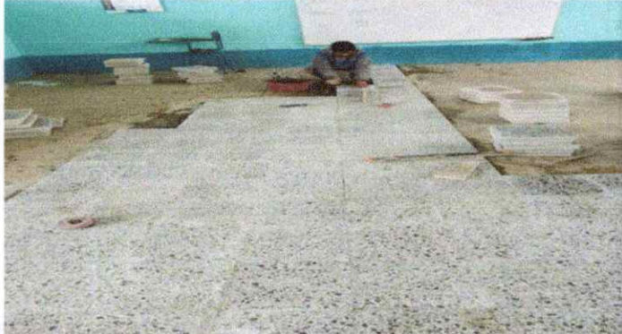
Foto 2 Sustrucción de piso de granito
