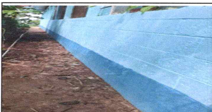
Foto 4 Reparación de cuneta de concreto
