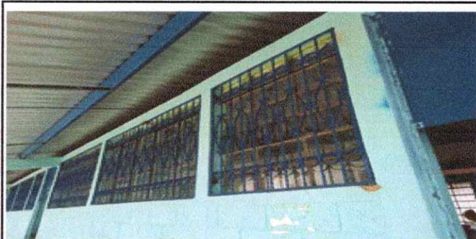
Foto 5 Pintura en muros exteriores e interiores
