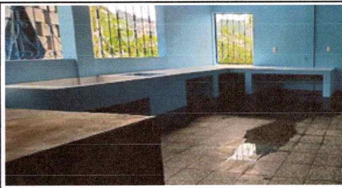
Foto 4: Colocación de azulejos en muebles
