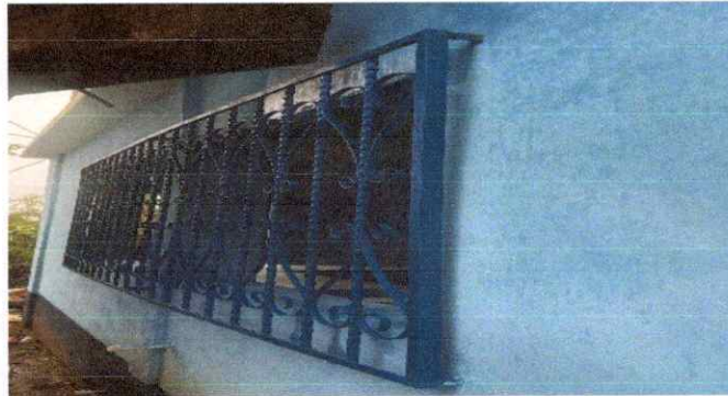
Foto 2: Sustrucción de balcones
