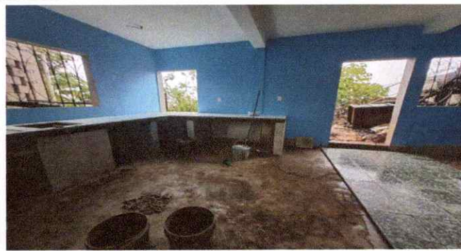
Foto 2: Sustrucción de balcones
