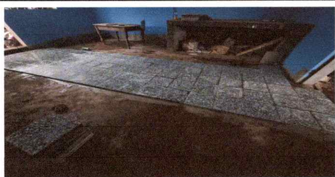
Foto 3: Sustrucción de piso
