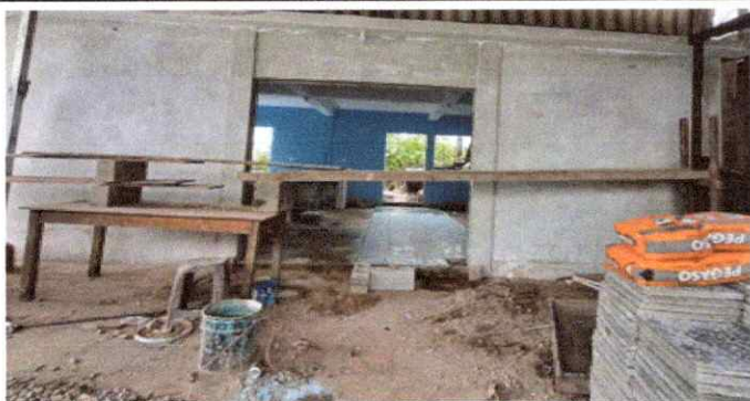
Foto1: Sustrucción de puerta
