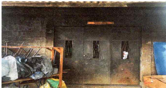
Foto 10: Sustitución de potón de metal.
