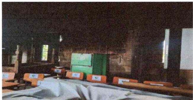
Foto1: Sustrucción de puerta
