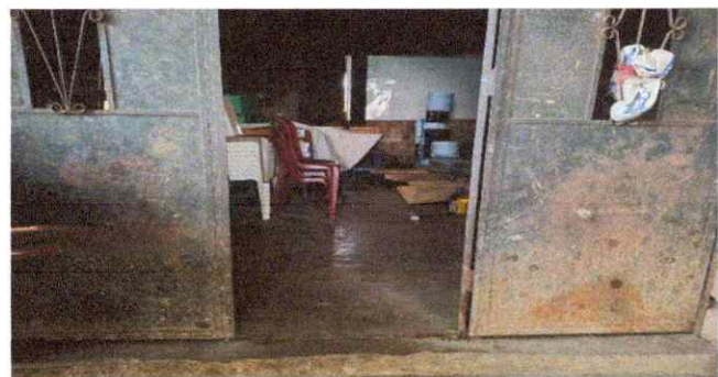
Foto 3: Sustrucción de piso
