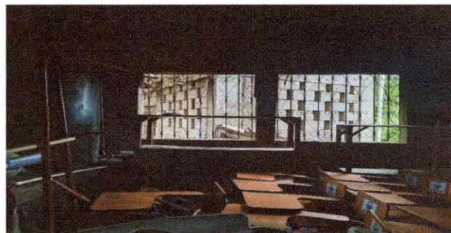
Foto 2: Sustrucción de balcones
