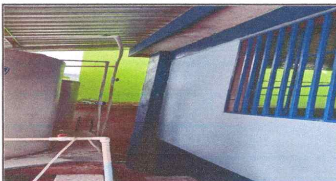
Foto 3: Trabajos finalizados en tubería línea principal de agua potable.
