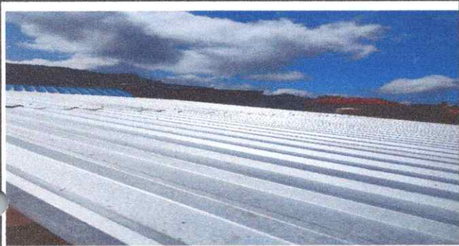
Foto1: Sustrucción de laminas finalizadas.
