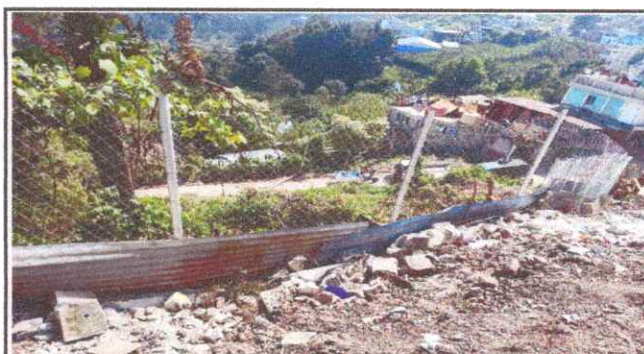
Foto 4: Trabajos finalizados en mejoramiento en circulación del predio.
