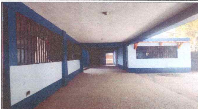
Foto 2: Trabajos finalizados en paredes.
