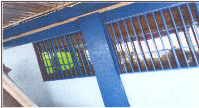
Foto 4: Mejoramiento en ventanas de metal finalizada
