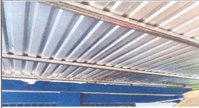
Foto 2: Sustrucción de estructura de soporte de madera, por metal finalizada
