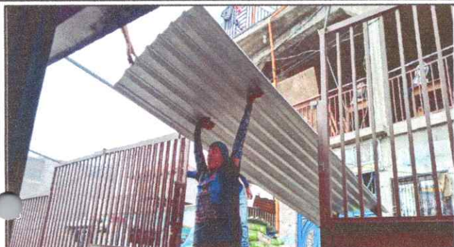
Foto1: Sustitución de laminas en mal estado.
