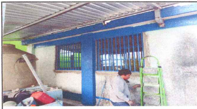
Foto 4: Trabajos realizados en mejoramiento en ventanas de metal
