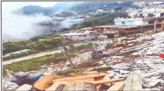
Foto 4: Trabajos realizados en mejoramiento en circulación del predio
