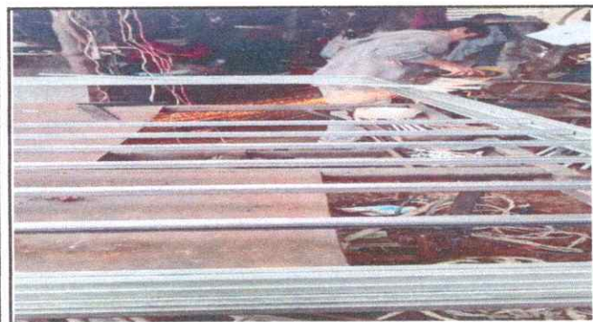
Foto 3: Mejoramiento de balcones de metal
