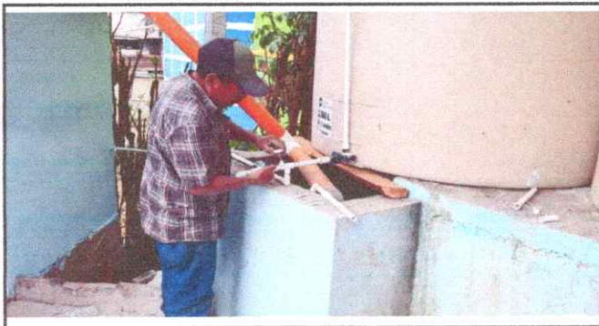
Foto 3: Trabajos realizados en tubería línea principal de agua potable en mal estado.
