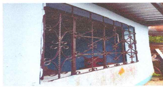
Foto 4: Mejoramiento en ventanas de metal
