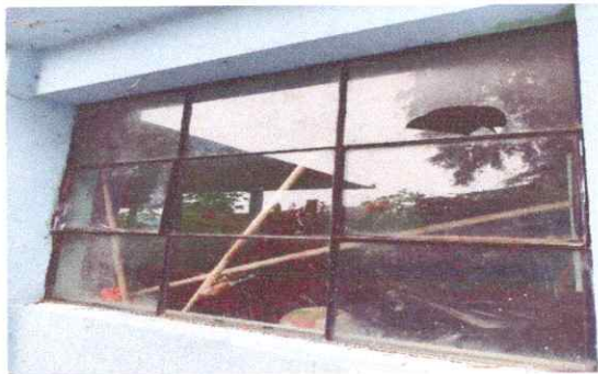
Foto 3: Mejoramiento de balcones de metal
