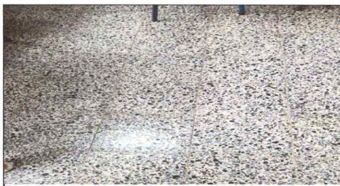
Foto 6: Sustrucion de piso de granito
