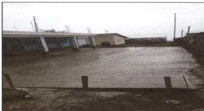
Foto 4: Mejoramiento de piso
