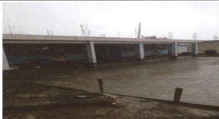
Foto 1: Sustrucion de plancha de concreto de piso
