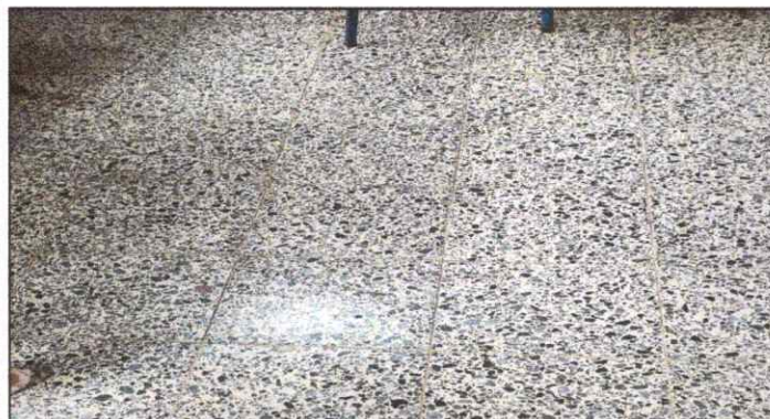
Foto 3: Sustrucion de piso de torta por granito
