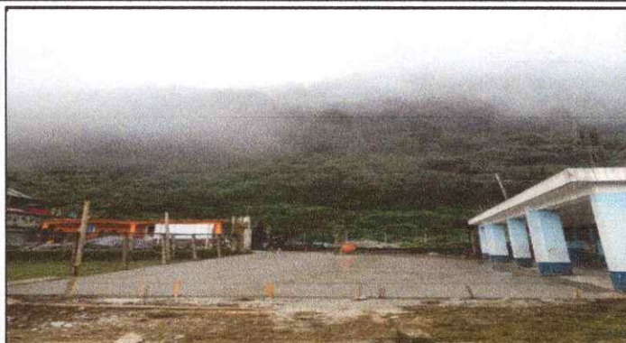
Foto 2: Sustrucion de plancha de concreto de piso
