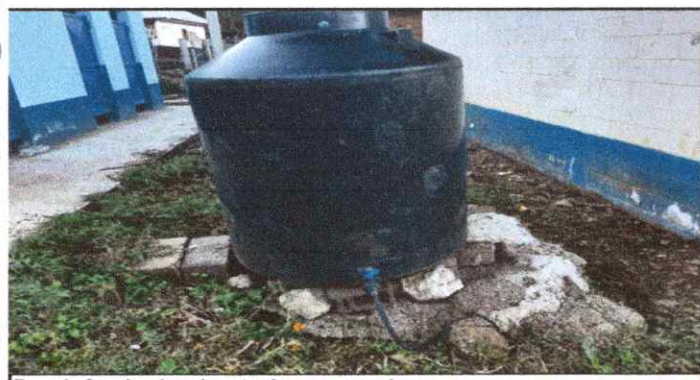
Foto 6: Sustitucion de rotoplas por rotoplas
