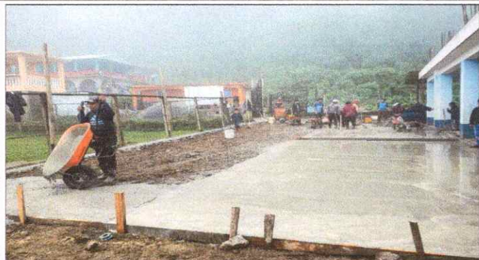
Foto 1: Sustitucion de plancha de concreto de piso
