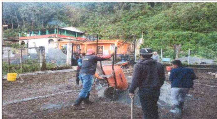
Foto 2: Sustitucion de plancha de concreto de piso
