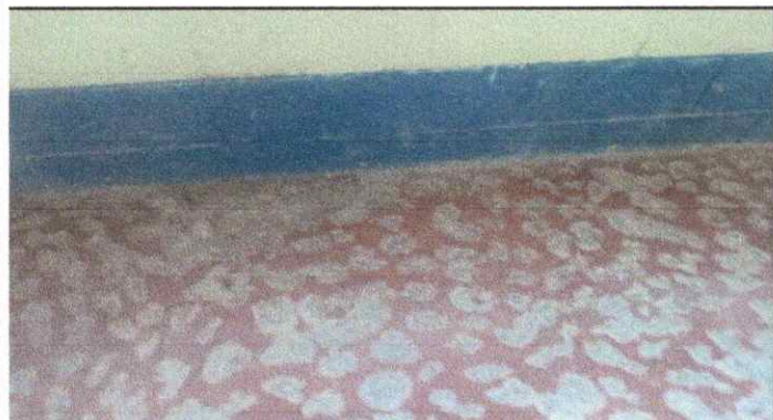
Foto 3: Sustitucion de piso de torta por granito
