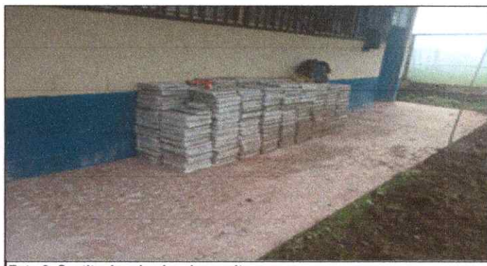
Foto 6: Sustitucion de piso de granito
