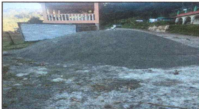
Foto 4: Mejoramiento de piso
