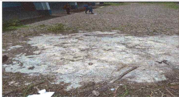
Foto 1: Sustitucion de plancha de concreto de piso
