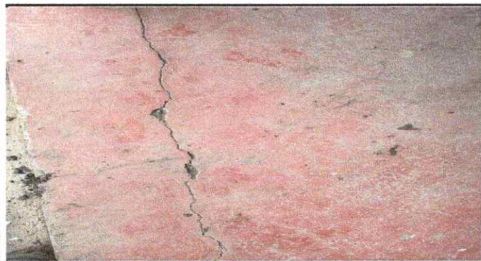
Foto 3: Sustitucion de piso de torta por granito
