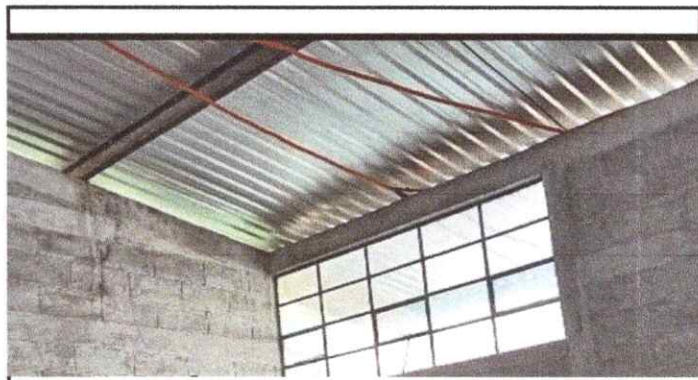
Foto 4: Mantenimiento a estructura
