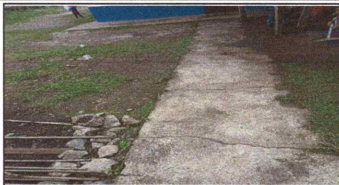
Foto 2: Sustitucion de plancha de concreto de piso
