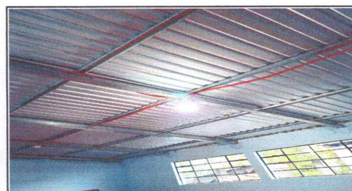
Foto 6: Reparación del sistema eléctrico
