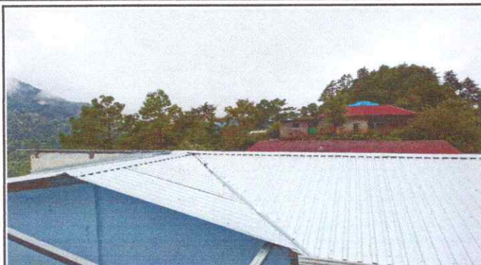
Foto 1: Sustitución de lámina por lámina troquelada
