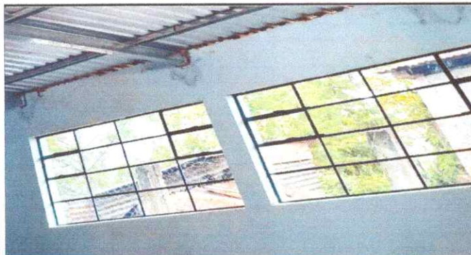
Foto 3: Sustitución de Vidrios
