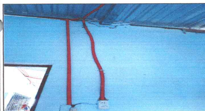
Foto 5: Sustitución de cableado de energía eléctrica
