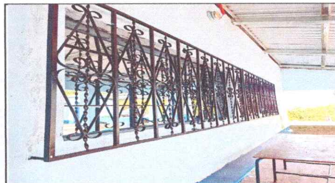
Foto 4: Colocación de balcones
