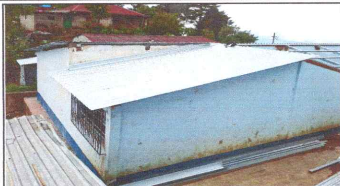
Foto 1: Sustitución de lámina por lámina troquelada
