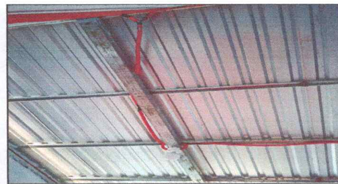
Foto 6: Reparación del sistema eléctrico
