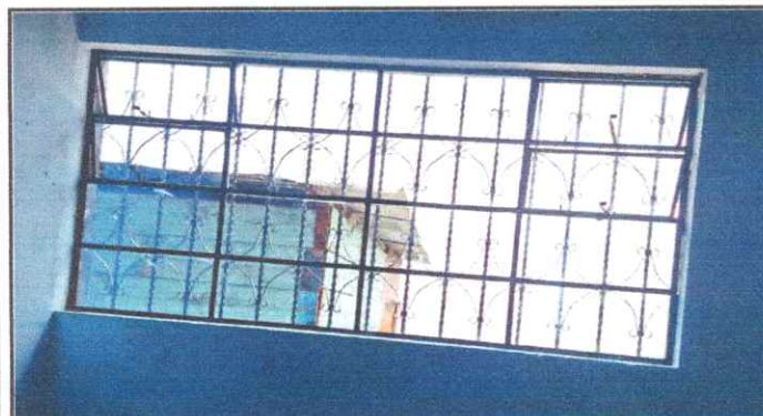
Foto 3: Sustitución de Vidrios
