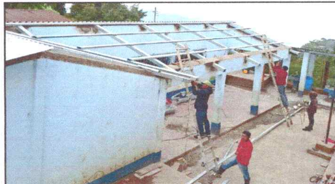
Foto 2: Sustitución de estructura de soporte de madera por metal y cambio de focos
