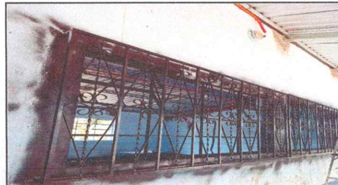
Foto 4: Colocación de balcones
