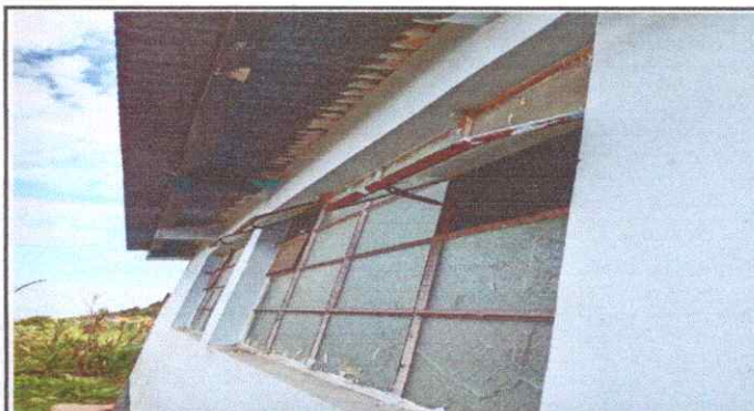
Foto 4: Colocación de balcones
