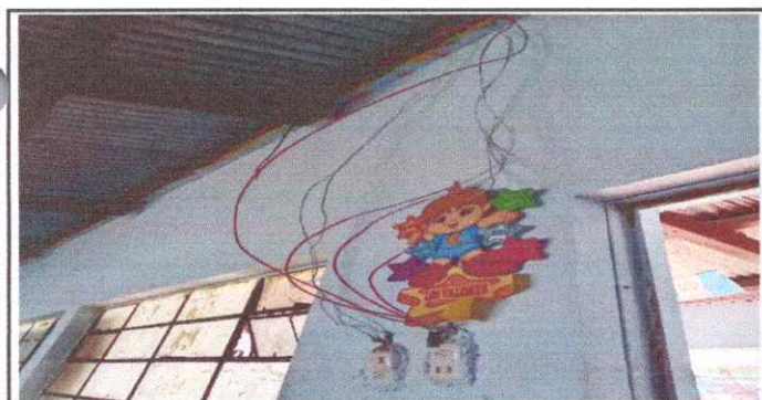
Foto 5: Sustitución de cableado de energía eléctrica
