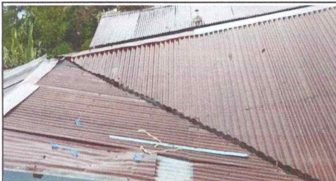
Foto 1: Sustitución de lámina por lámina troquelada
