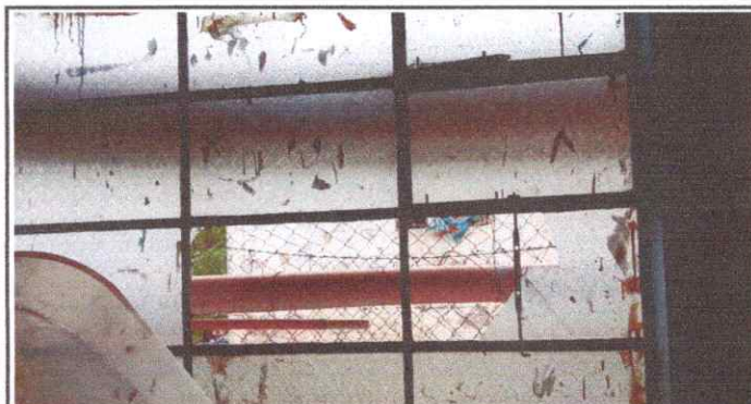
Foto 3: Sustitución de Vidrios
