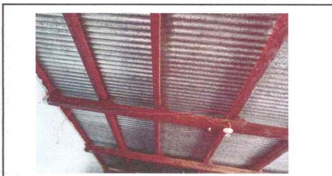
Foto 6: Reparación del sistema eléctrico
