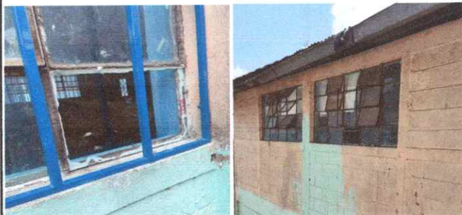
Foto No. 5 Sustitución de vidrios.
