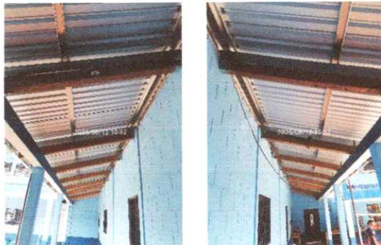
Foto No. 2 Estructura de soporte de techo de madera.
