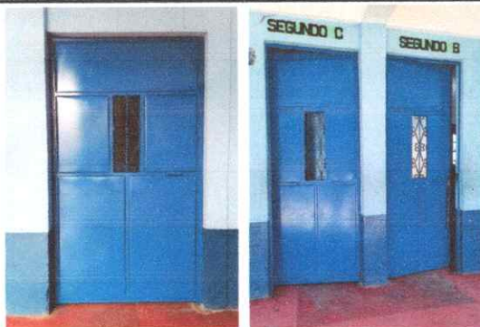
Foto No. 4 Mantenimiento a estructura de puerta de metal.
