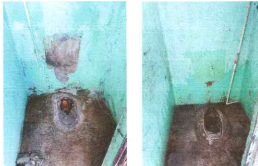
Foto No. 8 Sustitución de tazas sanitarias y accesorios infantiles.
