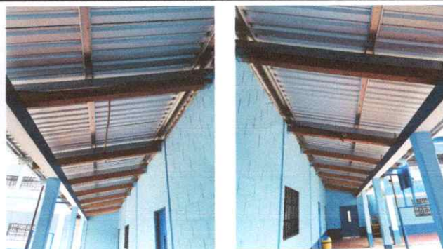
Foto No. 2 Estructura de soporte de techo de madera.
