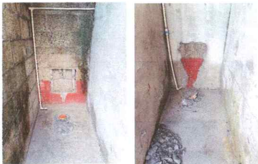
Foto No. 7 Sustitución de tazas sanitarias y accesorios grandes.
