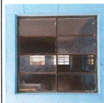
Foto No. 5 Sustitución de vidrios.
