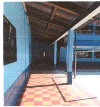
Foto No. 2 Estructura de soporte de techo de madera.
