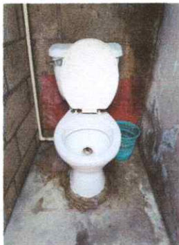
Foto No. 7 Sustitución de tazas y accesorios grandes.
