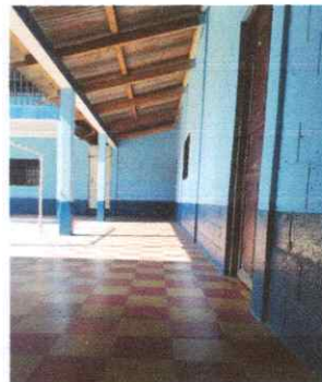
Foto No. 2 Estructura de soporte de techo de madera.
