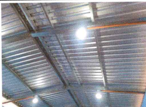
Foto 3: Acabado de instalación de luz eléctrica
