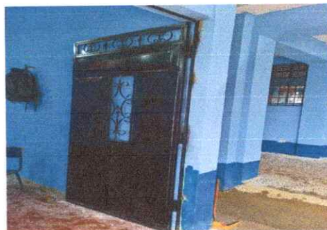
Foto 2: Puertas instaladas en buen estado
