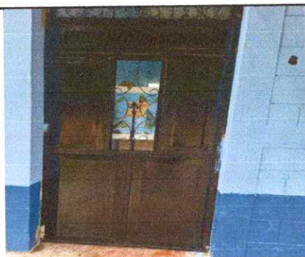
Foto 5: Instalación de puertas nuevas
