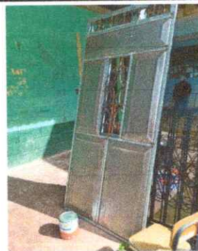
Foto 6: inicio de pintada de puertas
