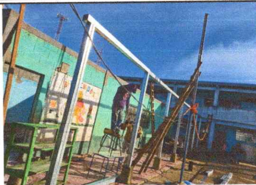
Foto 2: Colocando pilares de corredor
