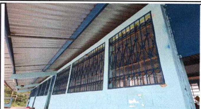
Foto 2 Mantenimiento a marcos de aluminio Mill Finish
