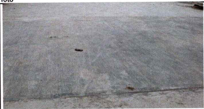
Foto 11 Reparación de torta de cemento
