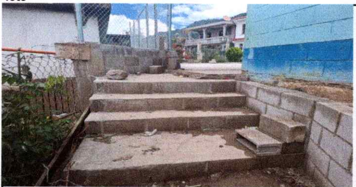
Foto 5 Reparación y ampliación de gradas
