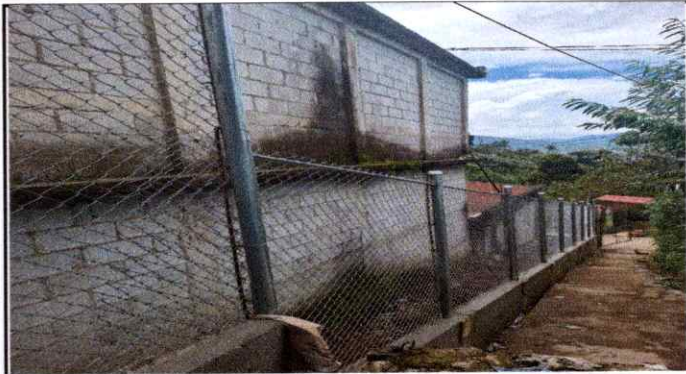
Foto 8 Reparación de tubo hg y malla galvanizada
