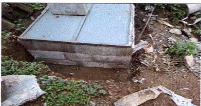
Foto 6 Sustitución de reposadera
