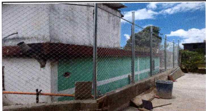
Foto 9 Reparación de tubo hg y malla galvanizada
