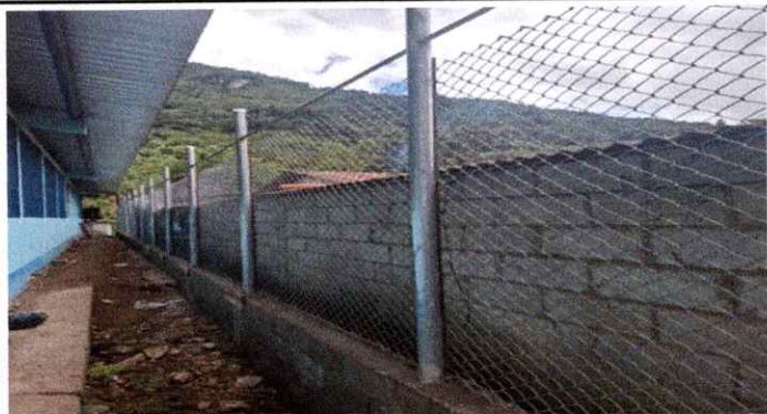
Foto 7 Reparación de tubo hg y malla galvanizada
