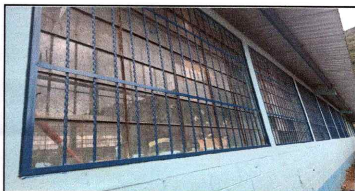
Foto 4 Sustitución de balcones
