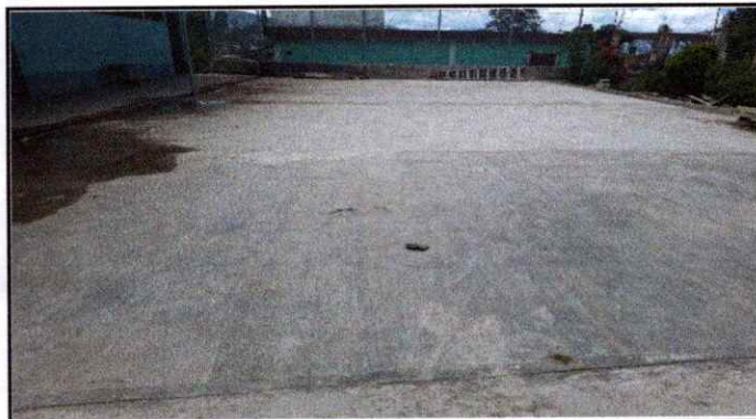
Foto 10 Reparación de torta de cemento
