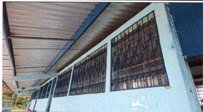
Foto 1 Mantenimiento a marcos de aluminio Mill Finish
