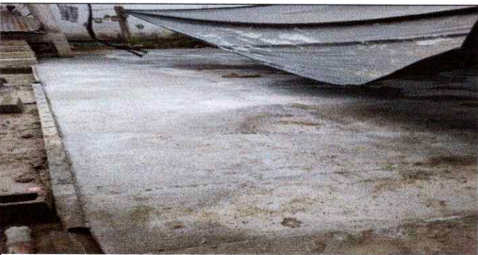
Foto 11 Reparación de torta de cemento
