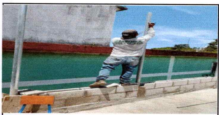
Foto 6 Reparación de tubo hg y malla galvanizada
