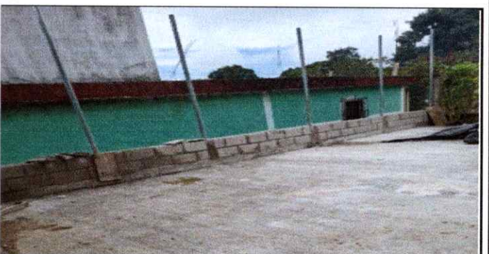
Foto 12 Reparación de torta de cemento
