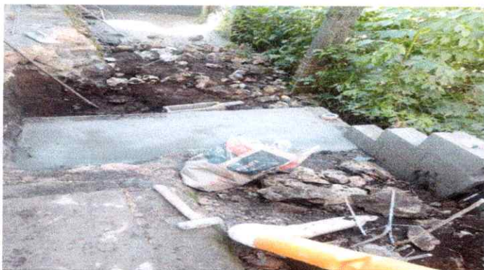
Foto 3 Reparación y ampliación de gradas
