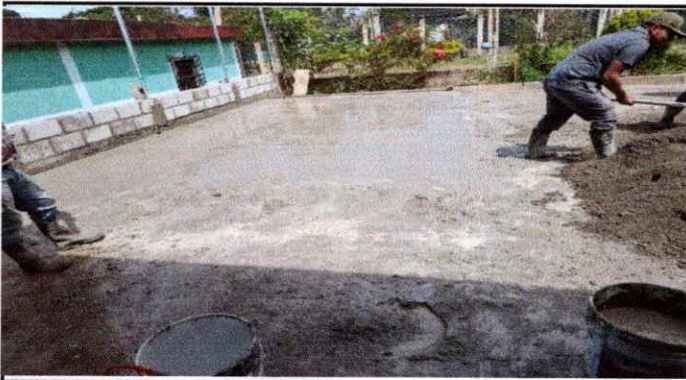
Foto 9 Reparación de torta de cemento
