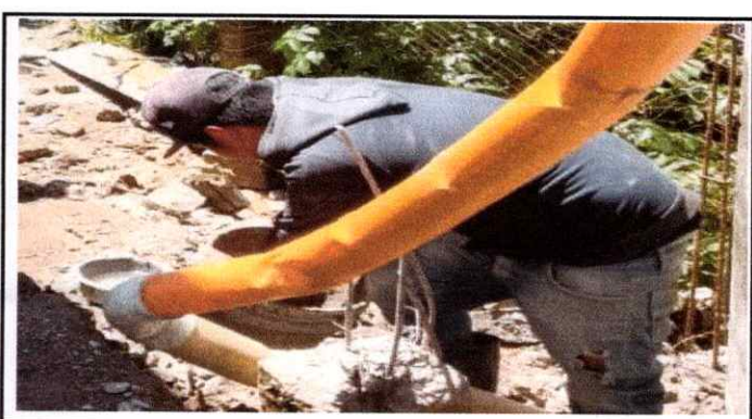
Foto 4 Sustitución de reposadera
