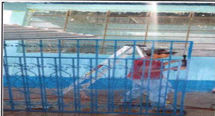
Foto 2 Sustitución de balcones
