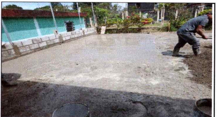
Foto 10 Reparación de torta de cemento
