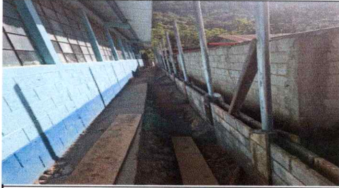
Foto 7 Reparación de tubo hg y malla galvanizada
