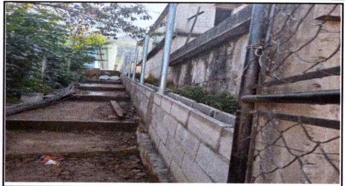
Foto 8 Reparación de tubo hg y malla galvanizada
