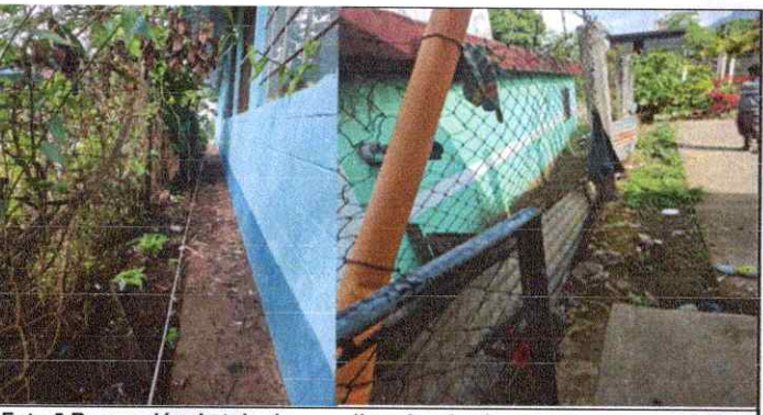
Foto 5 Reparación de tubo hg y malla galvanizada
