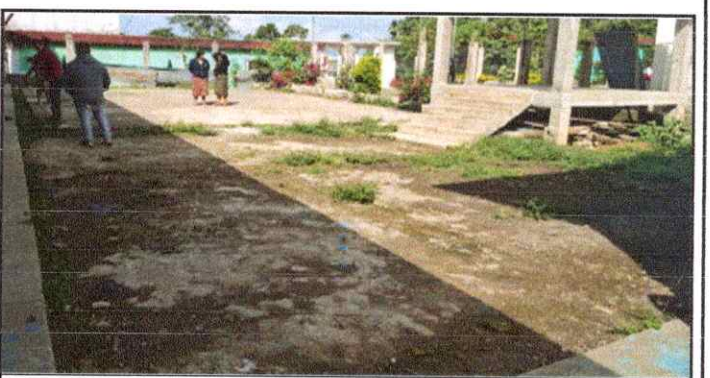
Foto 6: Reparación de torta de cemento
