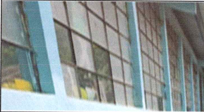
Foto 1 Mantenimiento a marcos de aluminio mill finish
