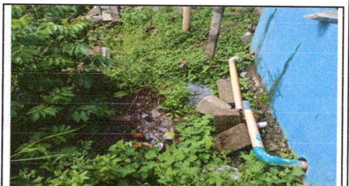
Foto 4 Sustitución de reposadera
