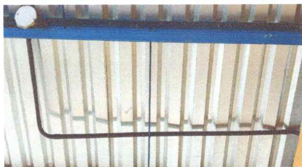
Foto No. 7: Finalización de instalación de cables.
