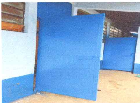
Foto No. 3: Mantenimiento a puertas finalizada.
