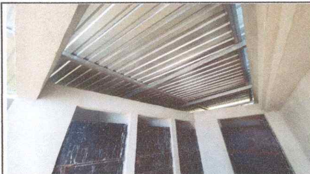
Foto No. 2: Finalización de estructura de soporte.
