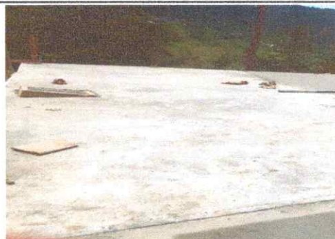
Foto No. 4: Finalización de planchas de concreto de patio.
