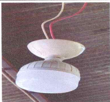
Foto No. 9: Finalización cambio de focos.
