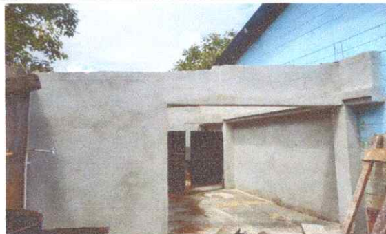
Foto No. 10: Finalización repello de paredes.
