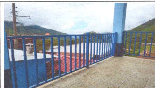
Foto No. 5: Sustitución de barandas finalizadas.
