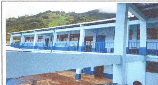
Foto No. 6: Finalización de pintado de paredes.
