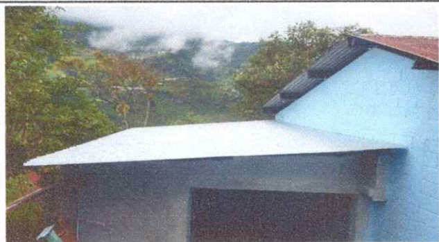
Foto No. 1: Finalización de sustitución de lámina.
