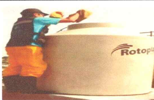
Foto No. 8: Trabajo de instalación de depósito de agua.
