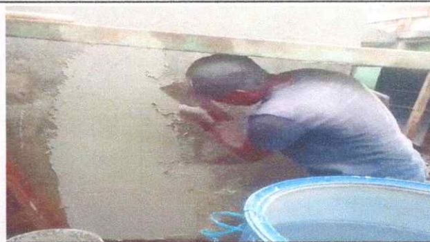
Foto No. 10: Repellado de paredes.
