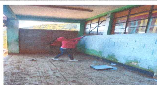
Foto No. 6: Trabajo en pintado de paredes.
