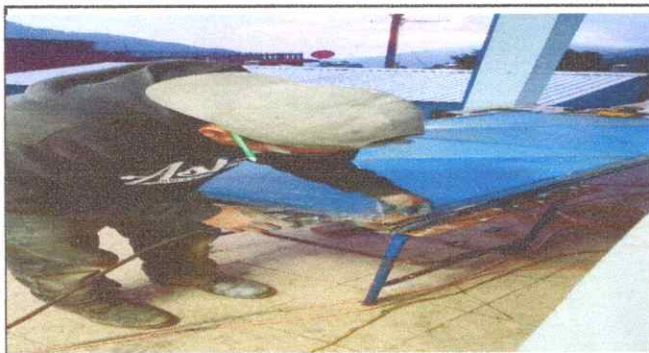
Foto No. 3: Arreglo de puertas en proceso.
