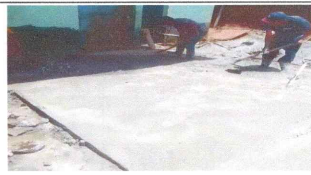
Foto No. 4: Trabajos realizados en planchas de concreto.
