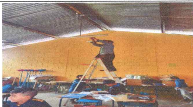
Foto No. 9: Trabajo de cambio de foco.
