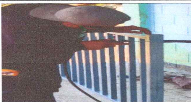
Foto No. 5: Trabajos realizados en barandas de metal.
