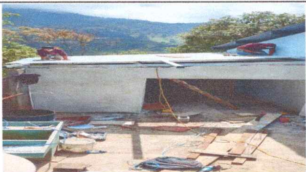
Foto No. 1: Trabajos realizados en sustitución de lámina.
