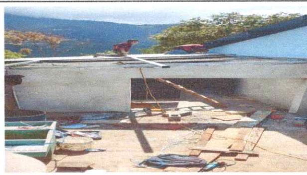
Foto No. 2: Trabajos en soporte de techo en proceso.
