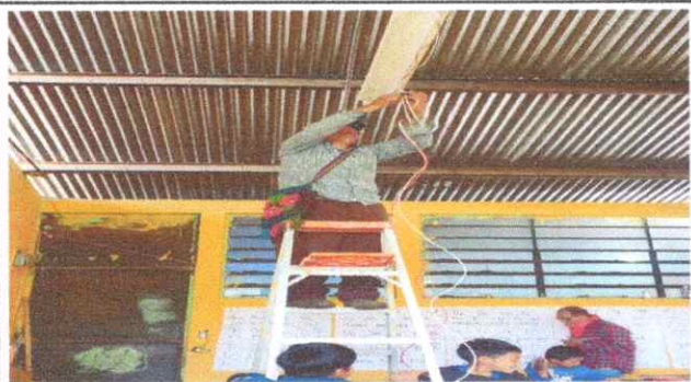
Foto No. 7: Trabajos de cambio de cables eléctricos.
