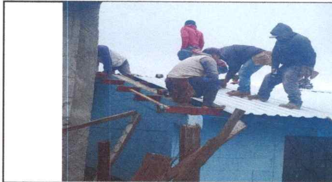
Foto1: Sustitucion de cubierta de Lámina en malas condiciones, totalmente cambiado
