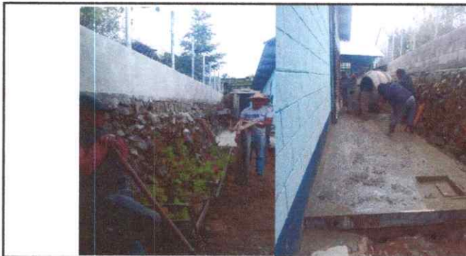
Foto 3: Cambio de tubería de aguas negras de sanitarios, se construye foza ceptica y drenaje de liquidos
