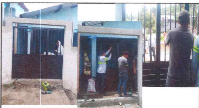
Foto 5: SUSTITUCIÓN DE PORTON DE MAYA GALBANIZADA POR PORTON DE METAL
