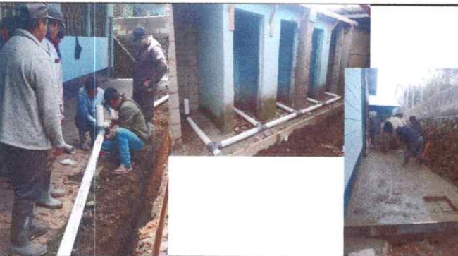
Foto 3: Cambio de tubería de aguas negras de sanitarios, construcción foza ceptica
