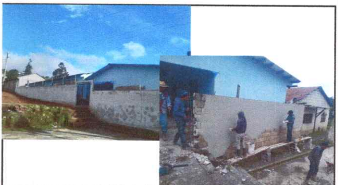
Foto 4: Mantenimiento de Muro Perimetral
