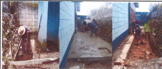
Foto 3: Cambio de tubería de aguas negras de sanitarios
