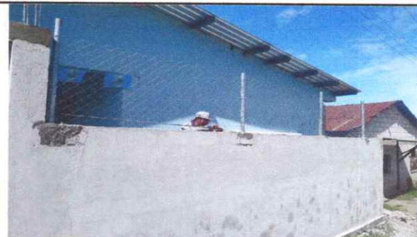
Foto 6: Mantenimiento de muro perimetral, repello y cierre de grietas
