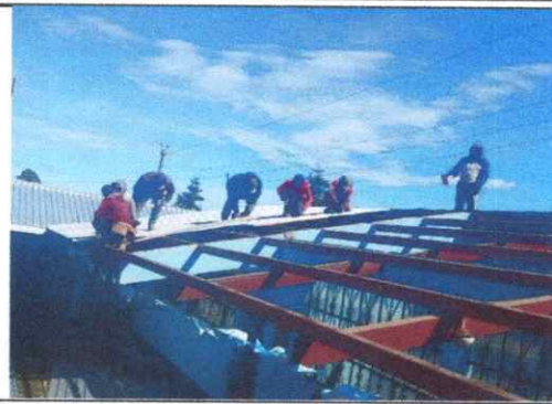
Foto 2: Sustitución cubierta de láminas
