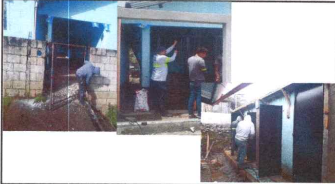
Foto1: Sustitución de puertas de letrina y porton principal
