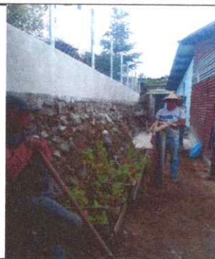
Foto 4: Mantenimiento de Muro Perimetral
