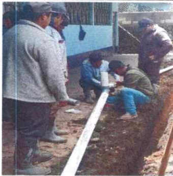
Foto 3: Cambio de tubería de aguas negras de sanitarios
