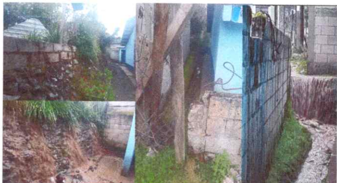
Foto 4: Mantenimiento de Muro Perimetral
