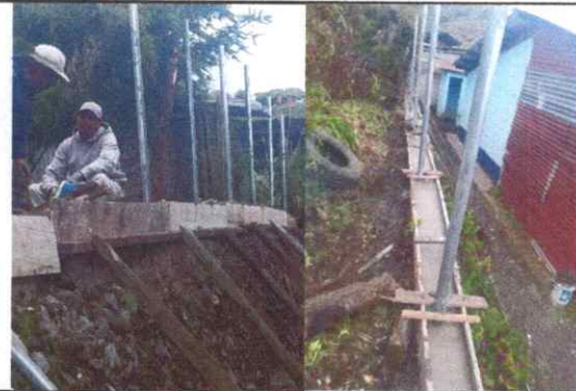
Foto 4: Mantenimiento de Muro Perimetral
