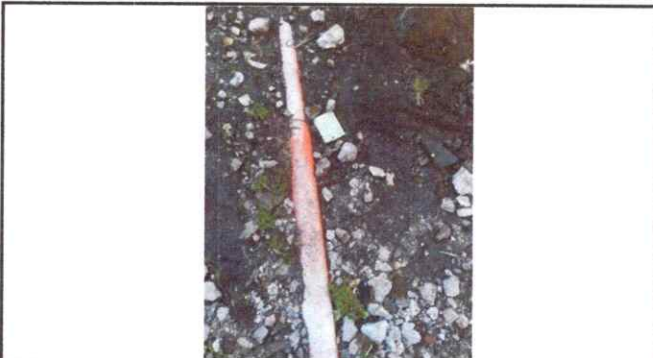
Foto 3: Cambio de tubería de aguas negras de sanitarios
