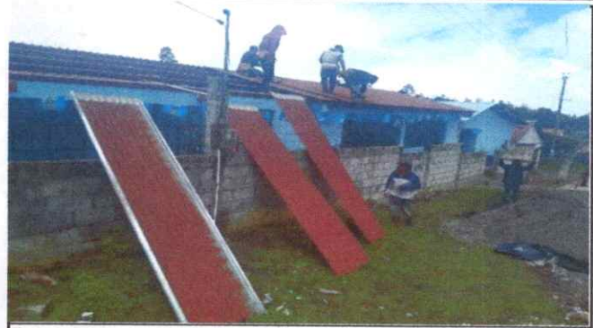
Foto 2: Sustitución cubierta de láminas
