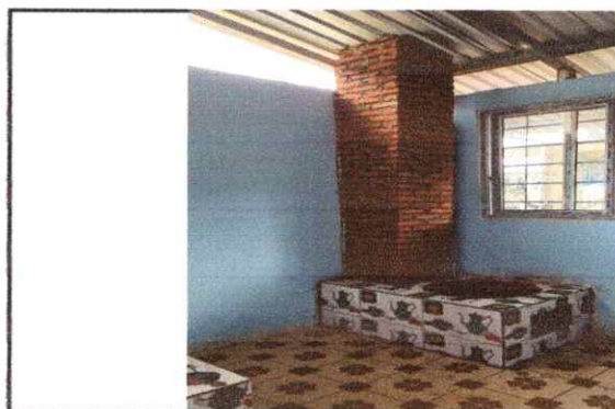
Foto No 6: Estufas rurales en mal estado y muros sin repello.
