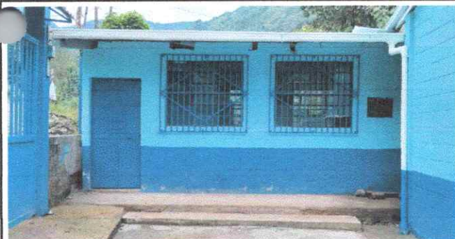
Foto No 5 : Instalación de canaletas de bajadas de agua
