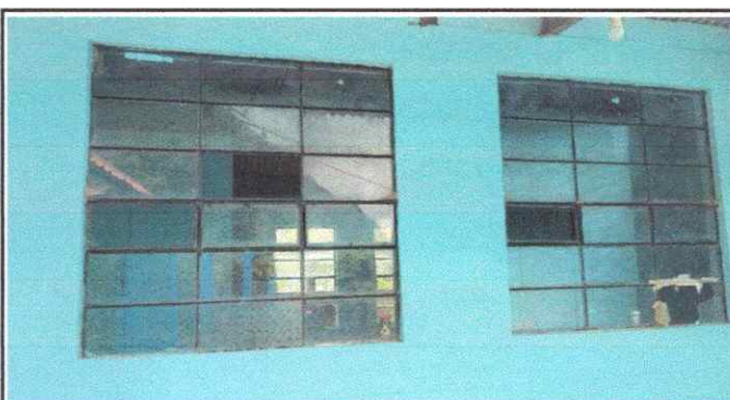
Foto No 4: Instalación de balcones
