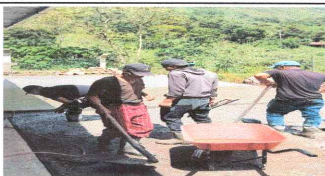
Foto No. 6: Losa de patio en mal estado
