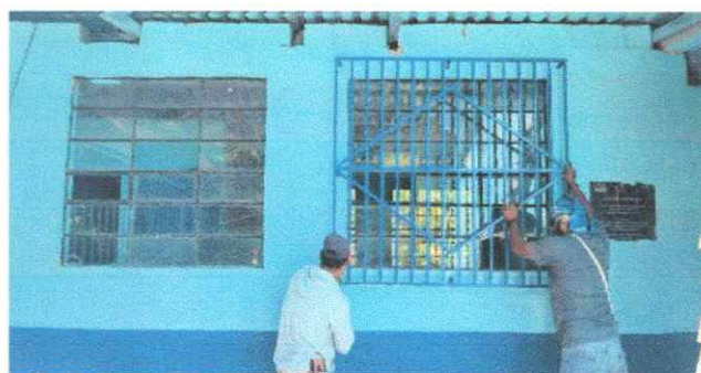
Foto No 4: Instalación de balcones
