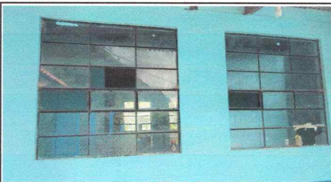
Foto No 4: Instalación de balcones
