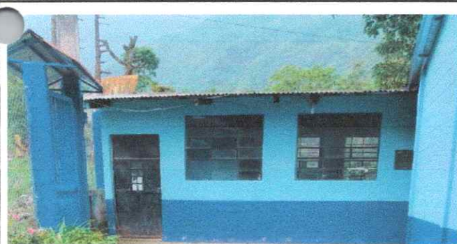
Foto No. 5: Instalación de canaletas de bajadas de agua
