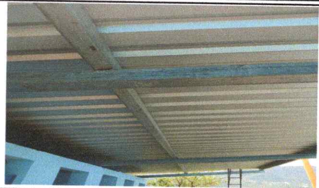
Foto 2: Estructura de soporte de techo terminado
