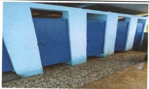
Foto 4: Colocación de piso granito
