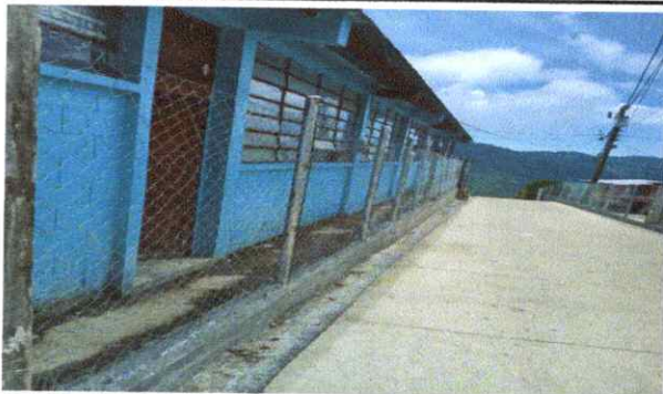
Foto 5: Circulación terminada de la escuela.
