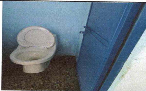
Foto 3: Instalación puerta de metal.
