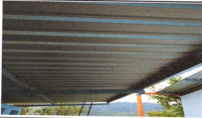
Foto 1: Colocación de lamina para techo terminado
