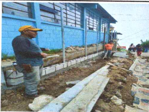
Foto 5: Colocación de block y tubo para la circulación
