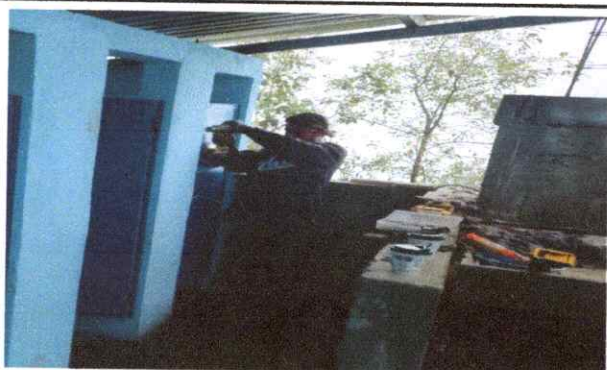
Foto 3: Instalación puerta de metal.
