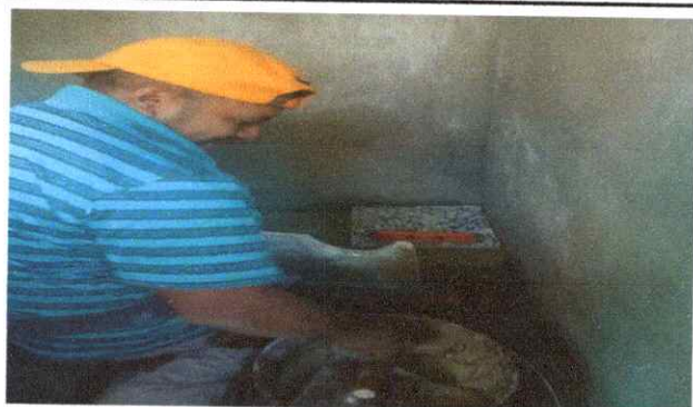
Foto 4: Colocación de piso granito
