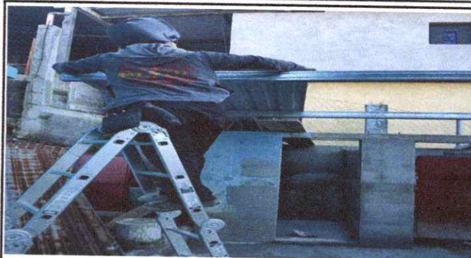
Foto 2: Estructura de soporte de techo
