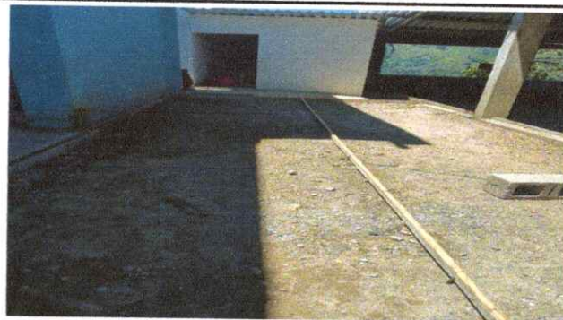
Foto 6: Fundicion de torta de cemento en el patio
