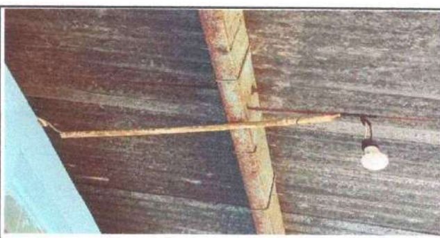
Foto No. 12: Sustitución de tubos ductos
