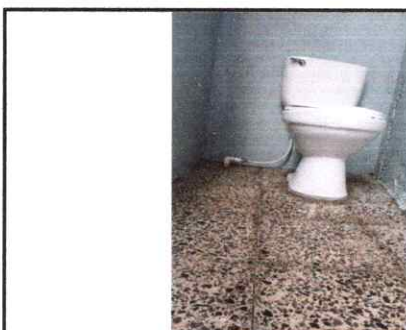
Foto 10. Renglón No. 6 Sustitución de inodoro
