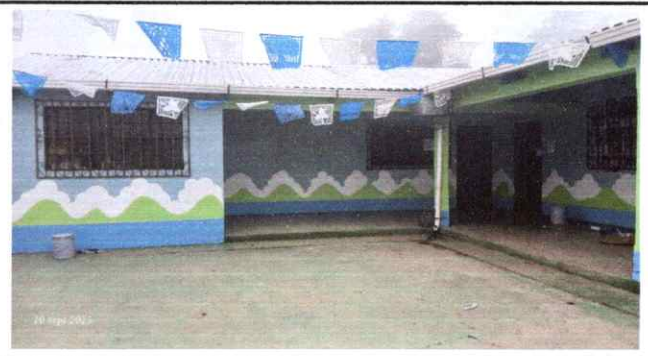
Foto 8: Renglon 5 Pintura en muros exteriores e interiores
