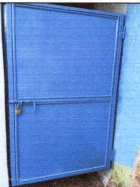
Foto 1: Renglon 1 Sustitución de puerta (1.46m de alto * 70cm de ancho)
