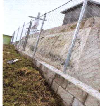
Foto 14. Renglón No. 9 Reparación de tubo hg y malla galvanizada.
