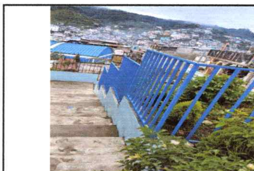
Foto 13. Renglón 8 Sustitución de barandas de metal.
