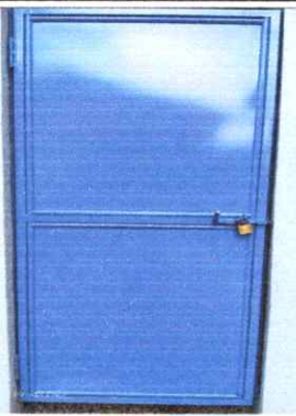
Foto 2: Renglon 1 Sustitución de puerta (1.46m de alto * 70cm de ancho)
