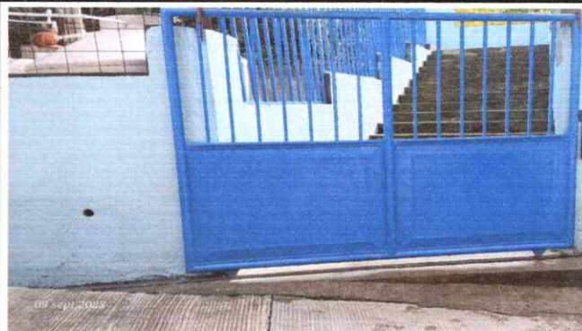
Foto 6: Renglon 3 Sustitución de portón de metal
