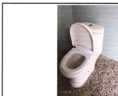
Foto 11. Renglón No. 6 Sustitución inodoro infantil
