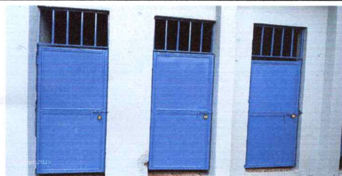
Foto 3: Renglon 2. Sustitución de puerta en servicios sanitarios
