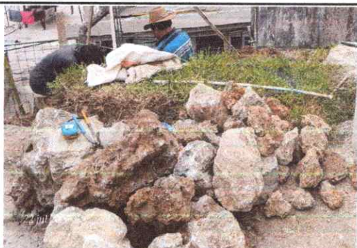
Foto 5: Renglón 4 Sustitución de piso de torta de concreto
