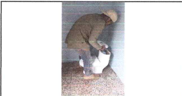
Foto 9. Renglón No. 6 Sustitución inodoro infantil
