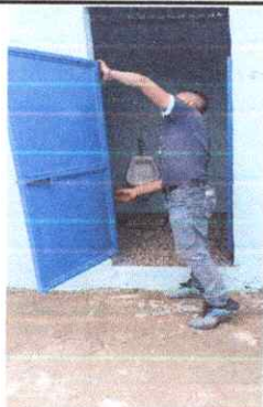
Foto 1: Renglón 1 Sustitución de puerta (1.46 m de alto por 70 cm de ancho)
