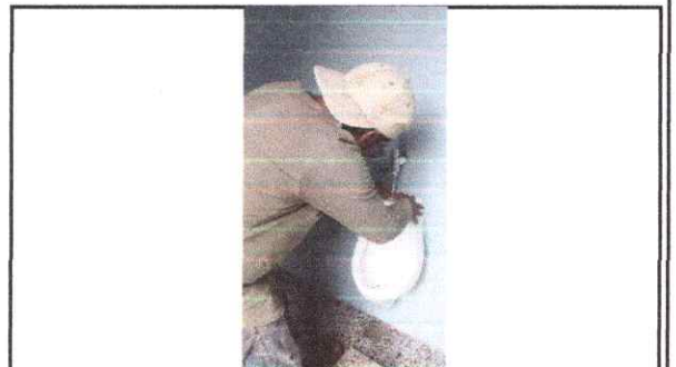
Foto 10. Renglón No. 7 Sustitución mingitorios
