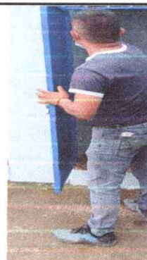
Foto 2: Renglón 1 Sustitución de puerta (1.46 m de alto por 70 cm de ancho)
