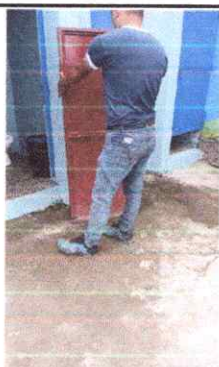
Foto 3: Renglón 2. Sustitución de puerta en servicios sanitarios
