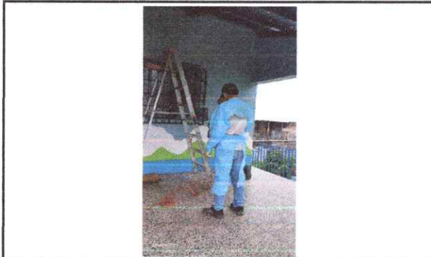
Foto 7: Renglón 5 Pintura en muros exteriores e interiores
