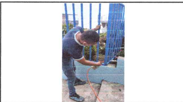
Foto 11. Renglón 8 Sustitución de barandas de metal.
