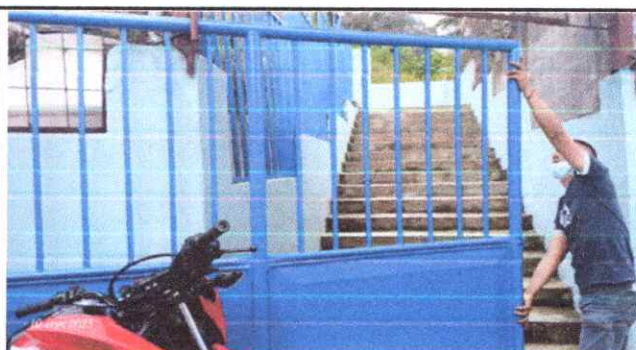
Foto 4: Renglón 3 Sustitución de portón de metal
