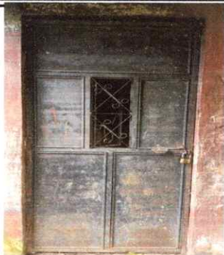
Foto 1: Renglon 1 Sustitución de puerta (2.10m de alto * 1.00m de ancho)
