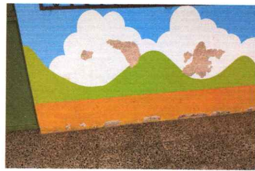
Foto 8: Renglón 5 Pintura en muros exteriores e interiores
