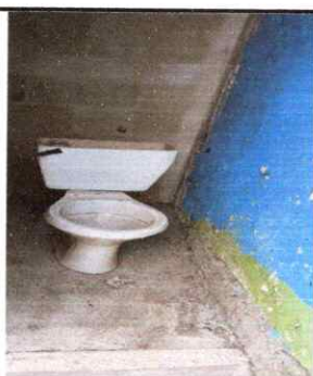
Foto 11: Renglón No. 6 Sustitución inodoro
