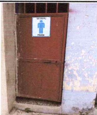
Foto 3: Renglón 2. Sustitución de puerta en servicios sanitarios
