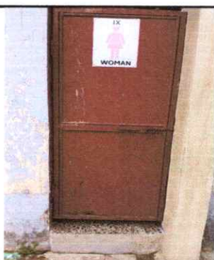
Foto 5: Renglón 2 Sustitución de puerta en servicios sanitarios
