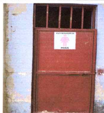
Foto 4: Renglón. 2 Sustitución de puerta en servicios sanitarios
