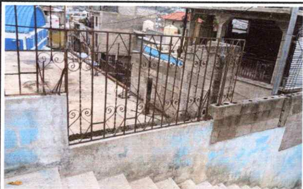
Foto 13. Renglón 8 Sustrucción de barandas de metal.
