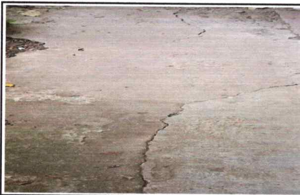
Foto 7: Renglón 4 Sustitución de piso de torta de concreto
