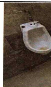
Foto 12: Renglón No. 7 Sustitución mingitorio
