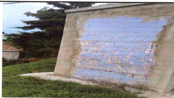
Foto 9: Renglón No. 5 Pintura en muros exteriores e interiores
